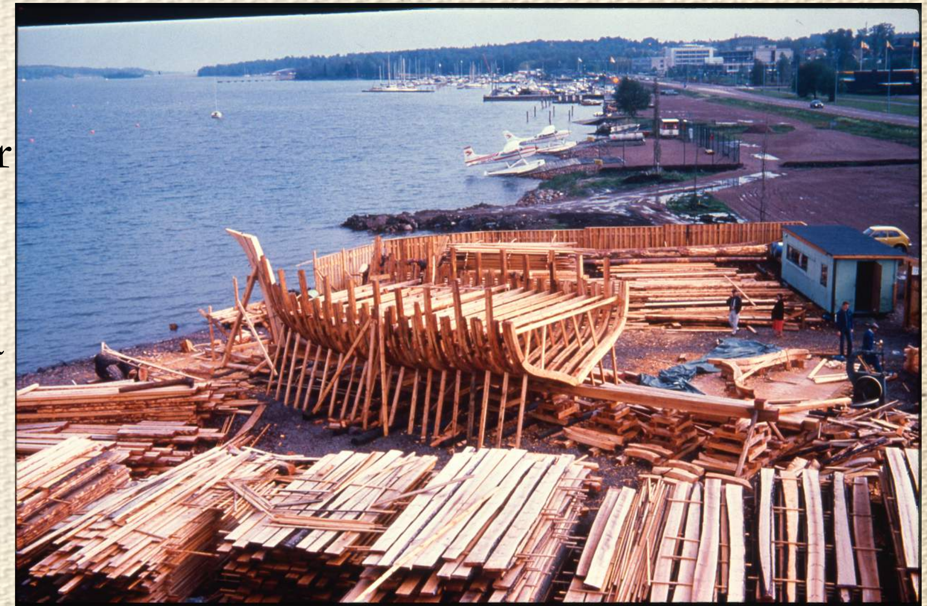
Albanus byggs i Östra Hamnen
